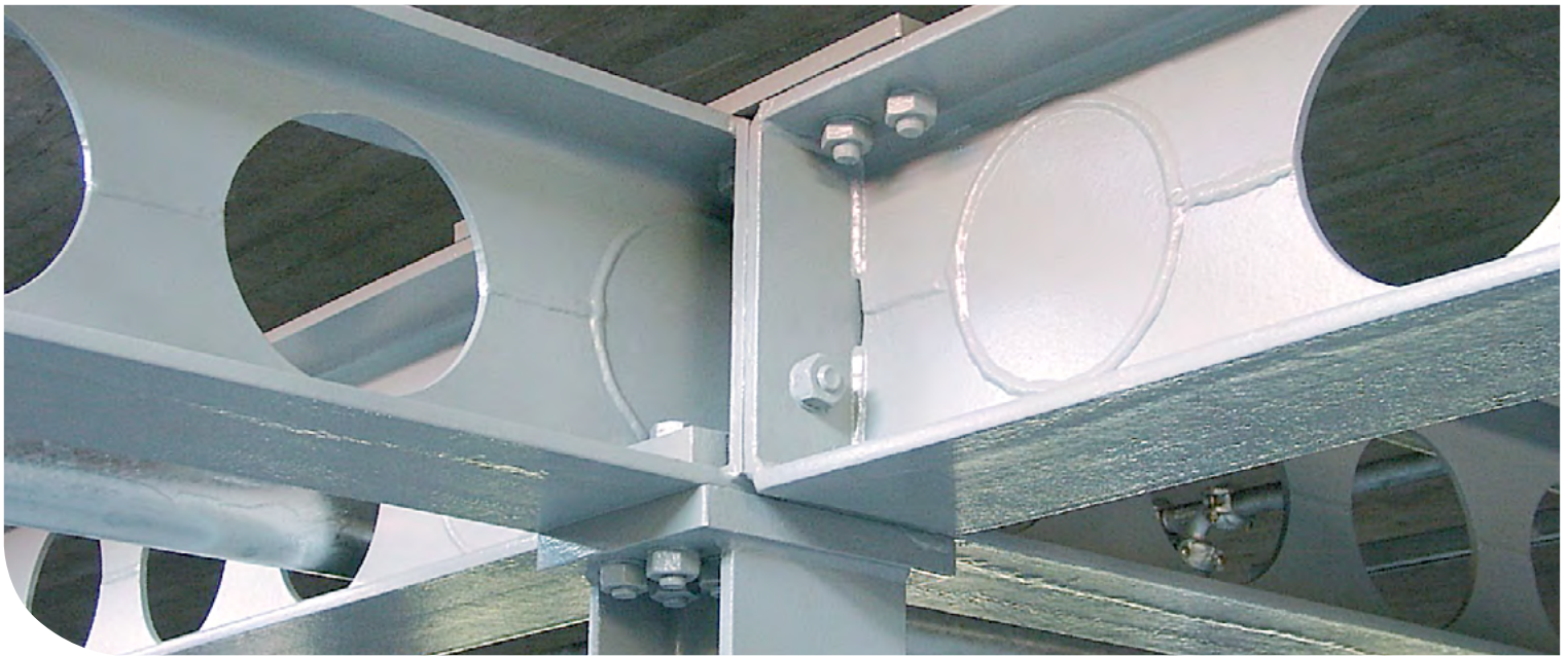
Beispiel von ACB® Trägern mit verschlossenen Öffnungen
