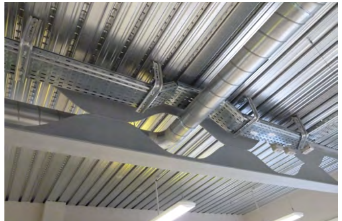
Abbildung 3: Angelina® Verbunddeckenträger
