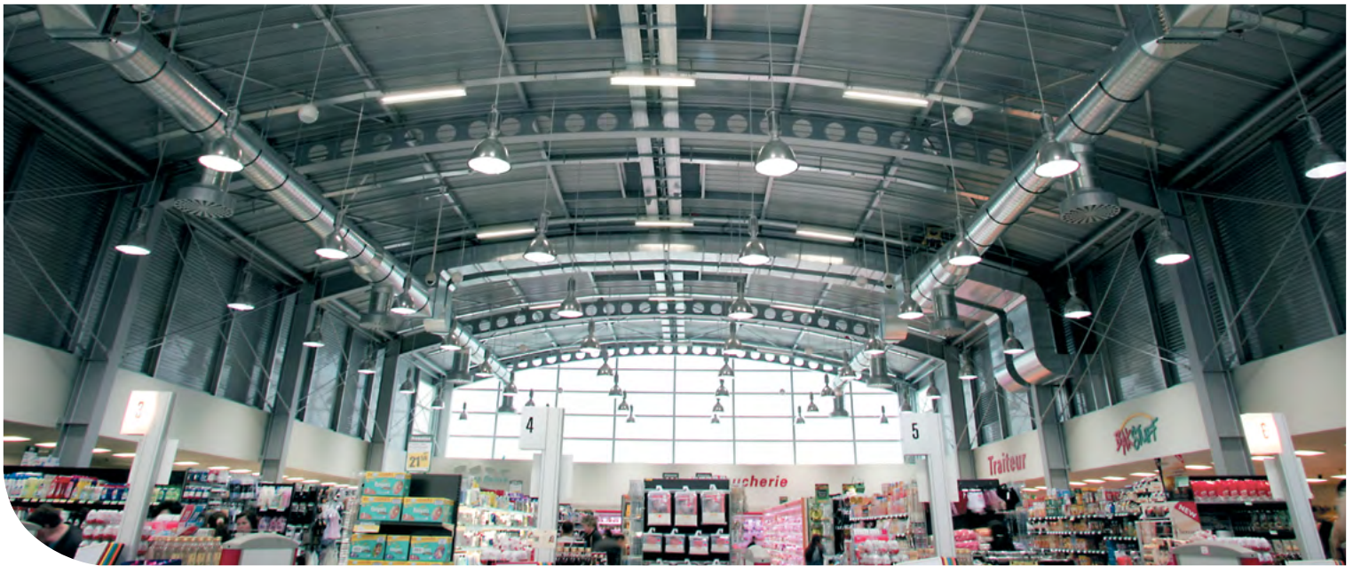
Tonnendach aus gebogenen ACB-Lochstegträgern mit 25m Spannweite
