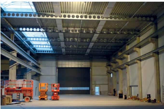
Abbildung 2: ACB® Lochstegträger in Dachtragwerk
